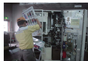
▲(オーバーホール) 分解工程
