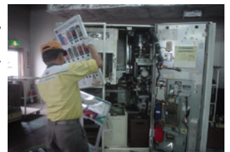
▲(オーバーホール) 分解工程
