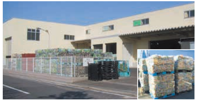
▲中部リサイクルセンター
