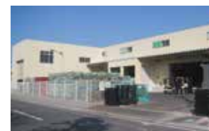
中部リサイクルセンター ※中部リサイクルセンターの詳細はP19をご参照ください。
